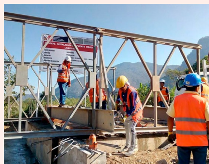
La instalación del puente modular se lleva a cabo en el distrito de Incahuasi, en la región Lambayeque.
